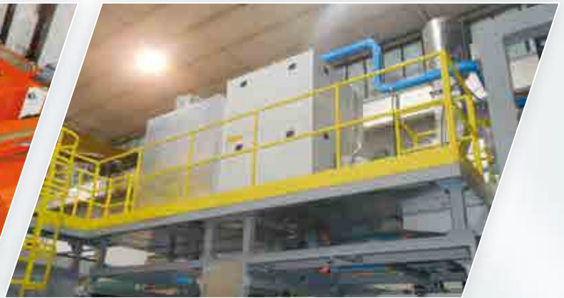
Cooling system 冷却系统
